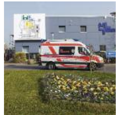
Titelfoto: Für rund 300 000 Euro wurde das Haus T energetisch saniert. Mit Übergabe der neuen Parkplätze pünktlich zum 1. April fielen auch hier die Gerüste.
