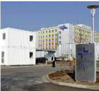
Ende des Jahres soll das Haus F komplett saniert sein. Bis dahin arbeitet die Verwaltung in einem Provisorium (links).
