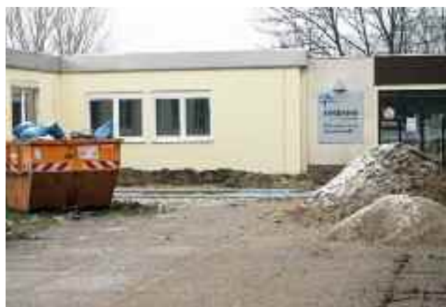
Hier entsteht der Interimgang, der Haus D mit dem Verwaltungsgebäude verbindet.
