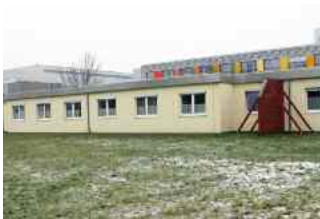
Dieser Gebäudeteil wird abgerissen und neu gebaut. Danach muss der restliche Altbau weichen.
