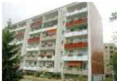
Vorn das bereits sanierte Gebäude, hinten das derzeit im Bau befindliche Objekt im Bruno-Beye-Ring.
